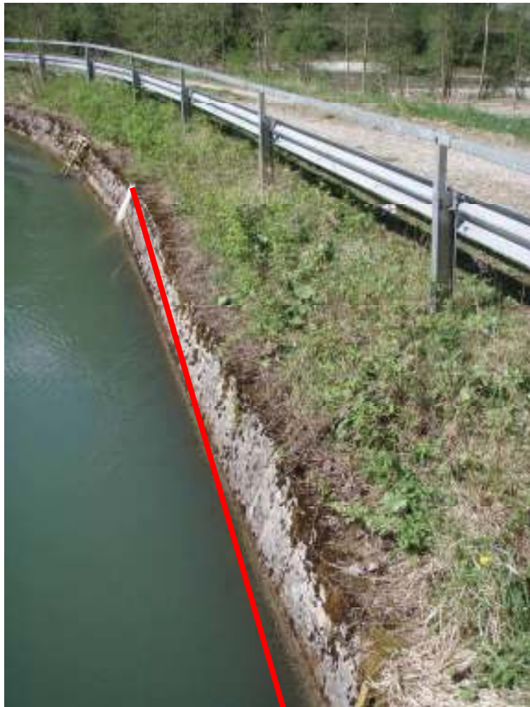
Abb. 19: Die Betonufer des Kanals zum Wasserspeicher von Hiefrau sind unmittelbar vor dem Eintritt in den Berg an beiden Ufern auf einer Länge von 20 m senkrecht ausgebildet, was für Otter und insbesondere andere Tiere zur akuten Gefahr werden kann, weshalb die Anbringung von schrägen Betonrampen (rote Linie) als Ausstiegshilfe dringend empfohlen wird.
