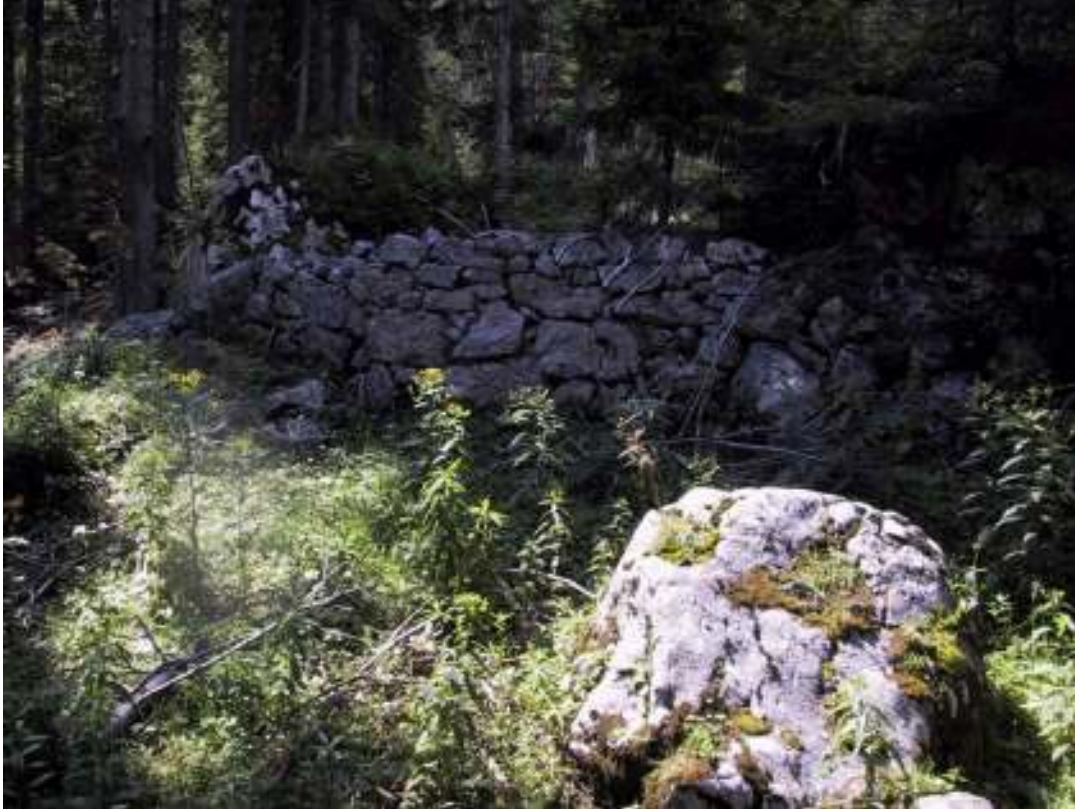
Steinmauer als Schutz vor dem Versturz westlich des Trepfels der ehemaligen Hüpflingeralm
