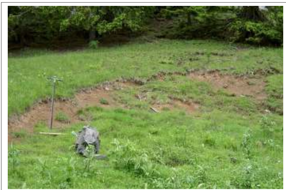
Abb.11 Hangrutschung bei Untersuchungsfläche Nr. 1
