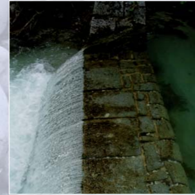
Beispiel für die alte „technische“ Bauweise (links) und für das neue ökologische Konzept (rechts) einer Grundschwelle. Fotos: Harald Haseke und Ernst Kren
