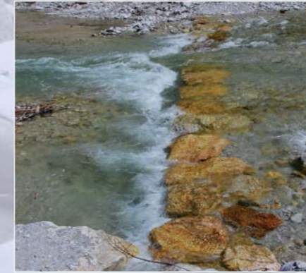
Beispiel für die alte „technische“ Bauweise (links) und für das neue ökologische Konzept (rechts) einer Grundschwelle. Fotos: Harald Haseke und Ernst Kren
